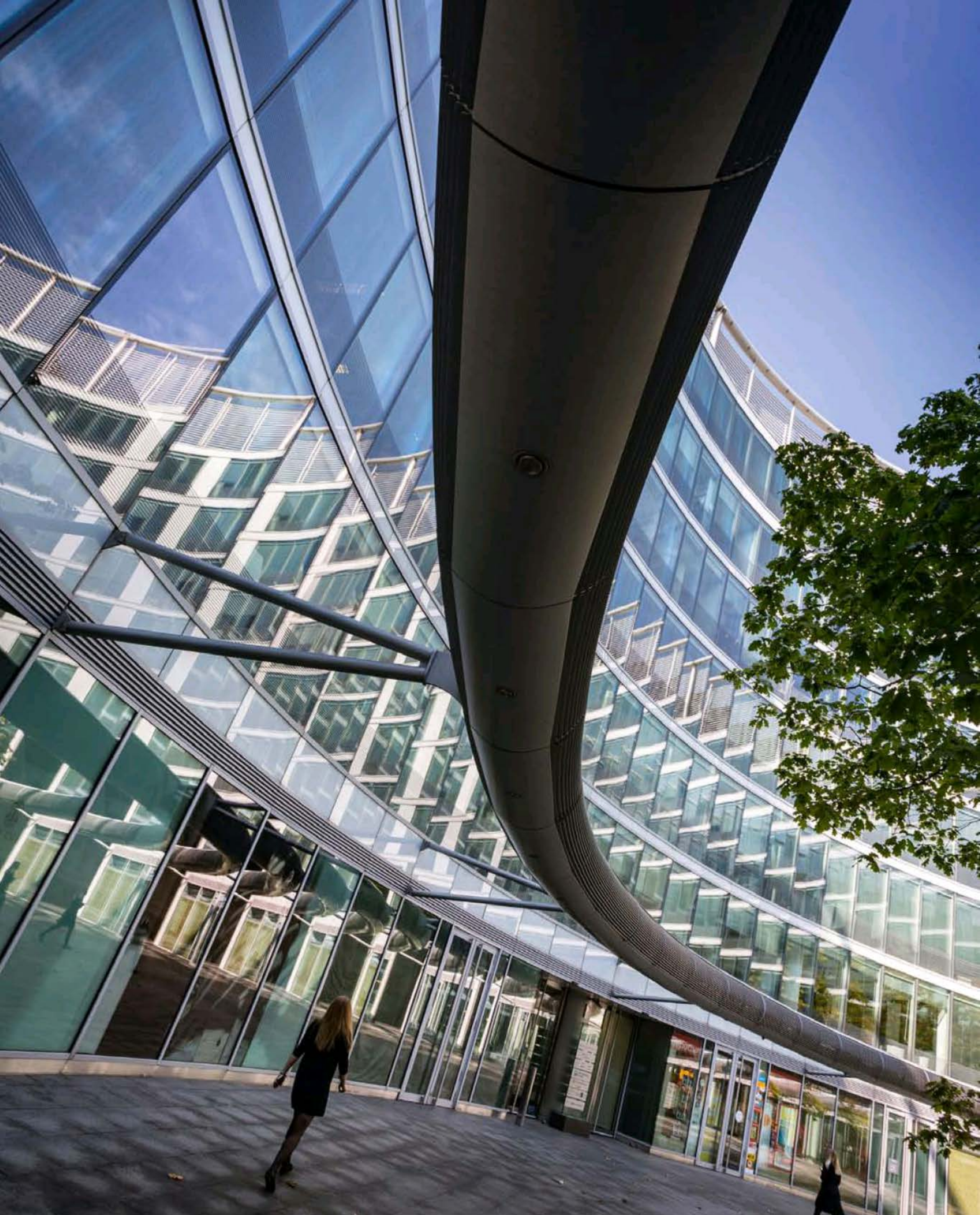
Edificio Metropolitan, obra de Norman Foster que marcó el inicio de la vanguardia arquitectónica en Polonia.
